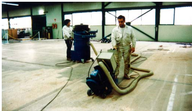
Preparación mecánica soportes
