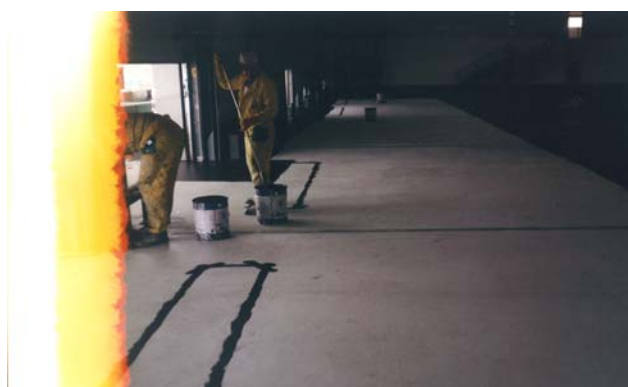
Sistema pintado Imprimación superconductora
