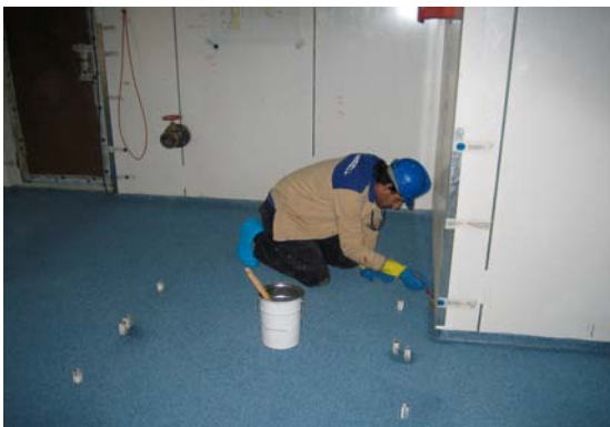
Sistema multicapa cuarzo-color Capa base
