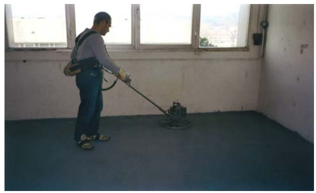
Sistema microterrazo liso Compactación y alisado
