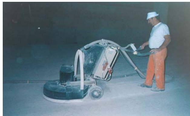
Preparación mecánica soportes
