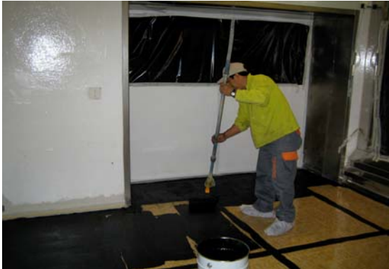
Sistemas capa gruesa Capa superconductora
