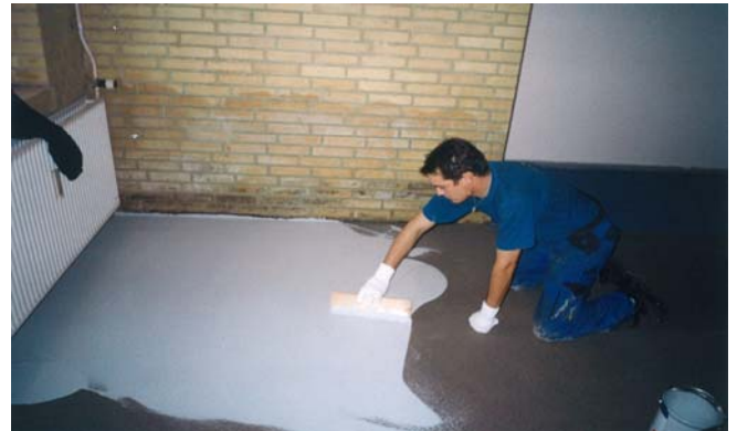
Sistema multicapa monocolor Capa sellado
