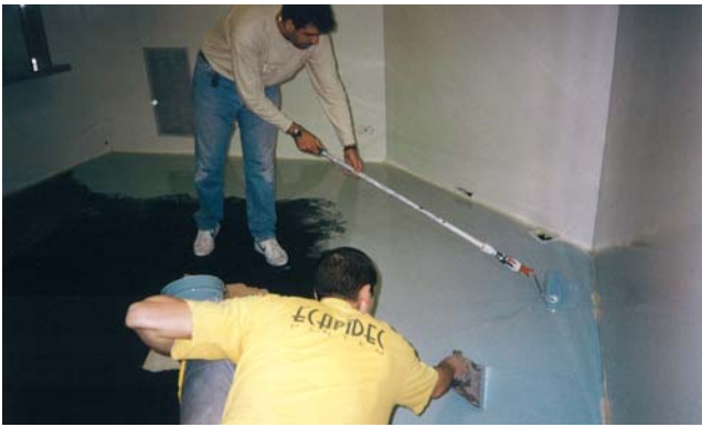
Sistema autonivelante Capa acabado
