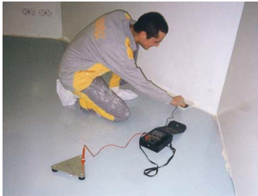
Control conductividad Sistema pintado
