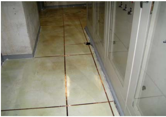
Sistemas capa gruesa Armadura de descarga
