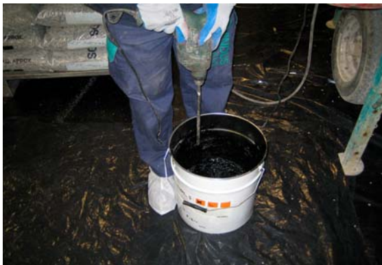
Sistema terrazo Preparación liqante
