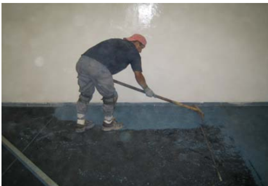
Sistema terrazo Perfileria metálica
