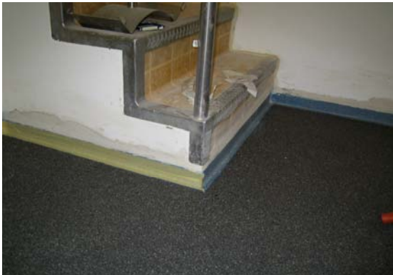
Sistema multicapa monocolor Capa base
