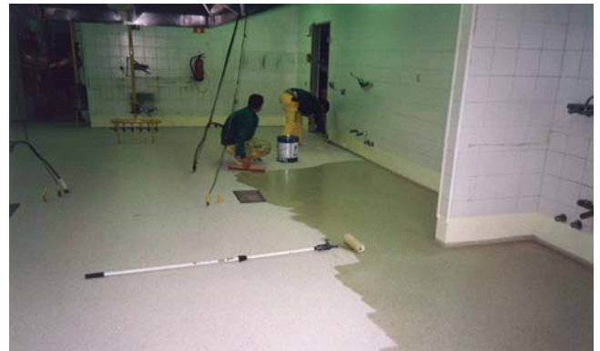
Sistema multicapa cuarzo+color Capa sellado
