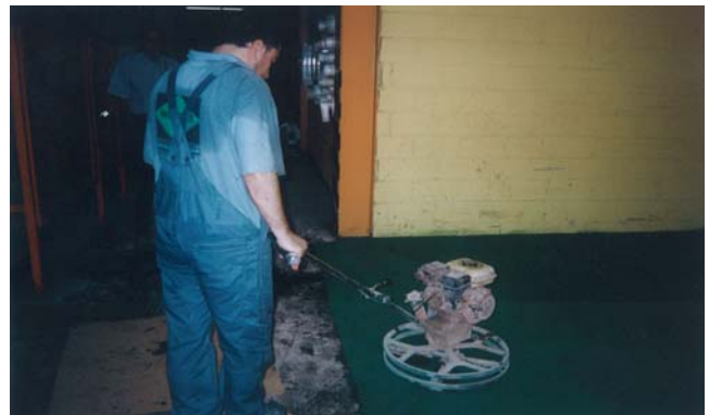
Sistema monocapa monocolor Capa base • Compactación y alisado
