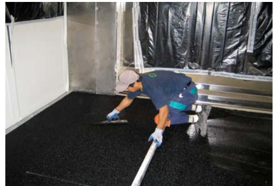
Sistema terrazo Aplicación mortero estructura
