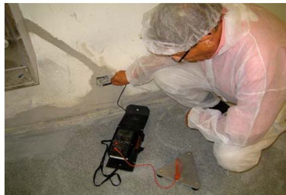
Control conductividad Sistema terrazo
