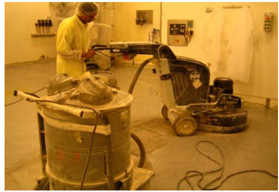
Sistema terrazo Rebaje y pulido
