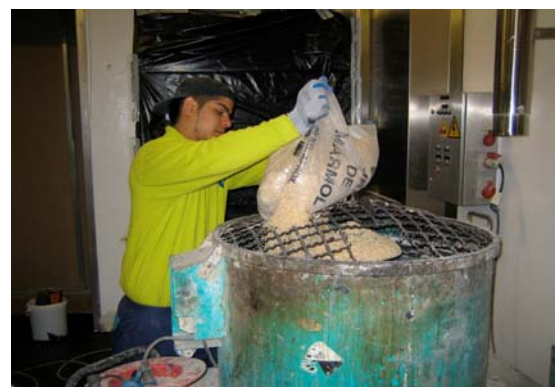
Sistema terrazo Preparación mortero estructura
